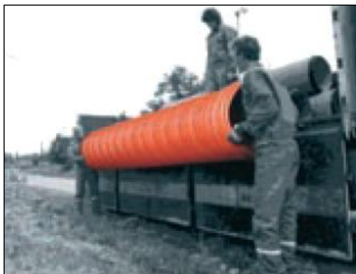
3 pav. Vamzdžių krovos darbai
